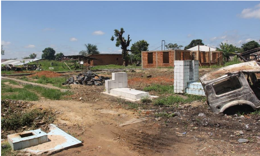
Photo n° 2 : Destruction du cimetière du rail
